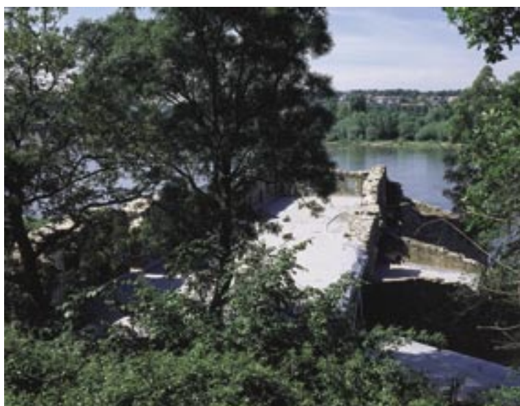
Étage. Vue d'ensemble depuis le sud.
