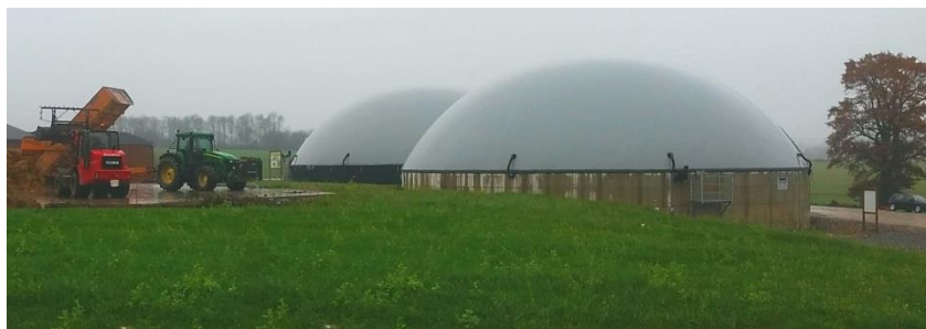
Méthanisation en voie liquide (Liffré-35. Planet biogaz)
